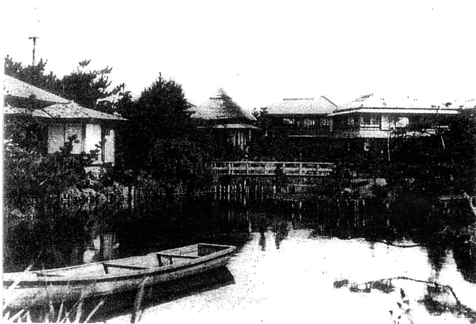
(上) 東屋の正門（震災前） (下) 東屋（池から本館を望む、震災前）
