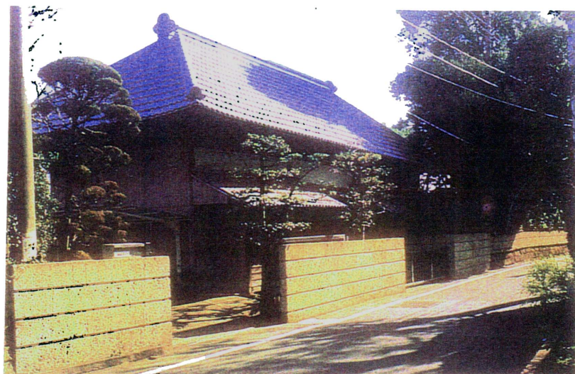
道路側からみた長屋門の全景
