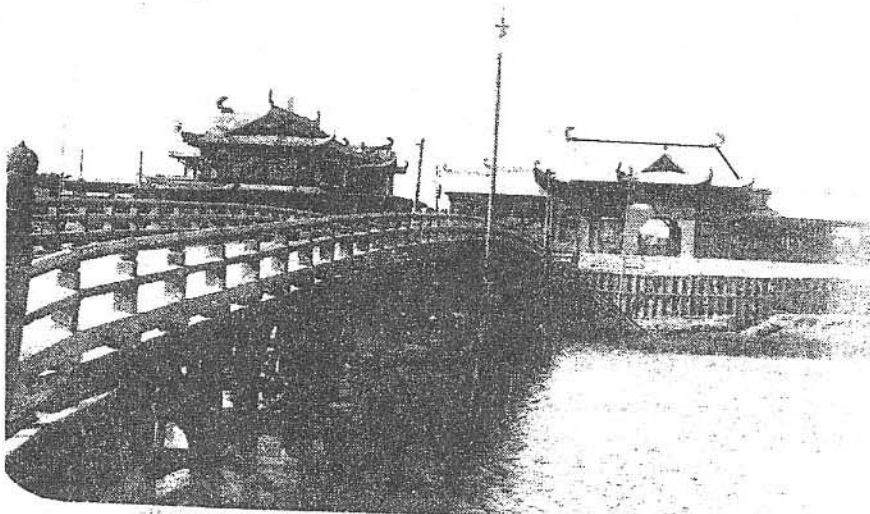
竜宮城の形の小田急片瀬江ノ島駅 (右側) 実は 6 ヶ月限りの仮駅だった
