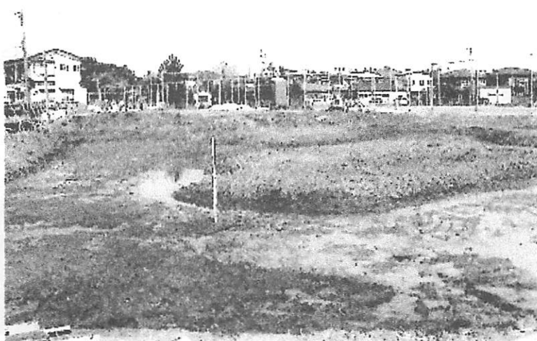
第一はす池の公園化工事 2005. 3. 21
