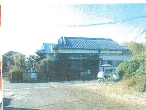
左銅板屋根は玄関、右側本屋根は瓦葺 右端切妻だが入母屋であったのでは？
