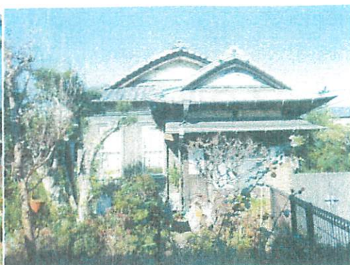
玄関・洋間を望む 上むくりの屋根、手前は銅板、奥は瓦
