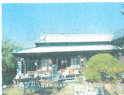
庭から…広縁・座敷・次の間の屋根 入母屋銅板葺きである。
