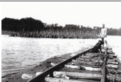
1938(昭和 13)年 7 月と 9 月の大洪水 江ノ電川袋付近の浸水
