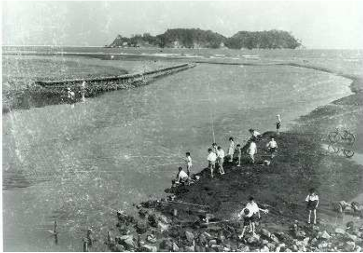
1950（昭和 25）年秋、引地川切り替え護岸が再度台風で先端が倒壊。河口は東に蛇行をはじめ、堤防の再構築が求められた。河口ではハゼがよく釣れた。
