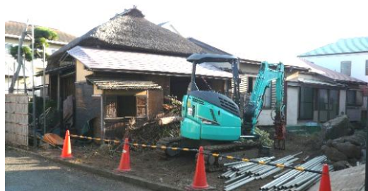
解体重機が入った江守邸 2020/8/25
