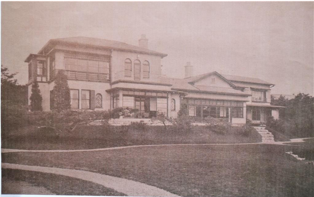
竣工当時の全景（昭和 9 年ころ撮影か）
