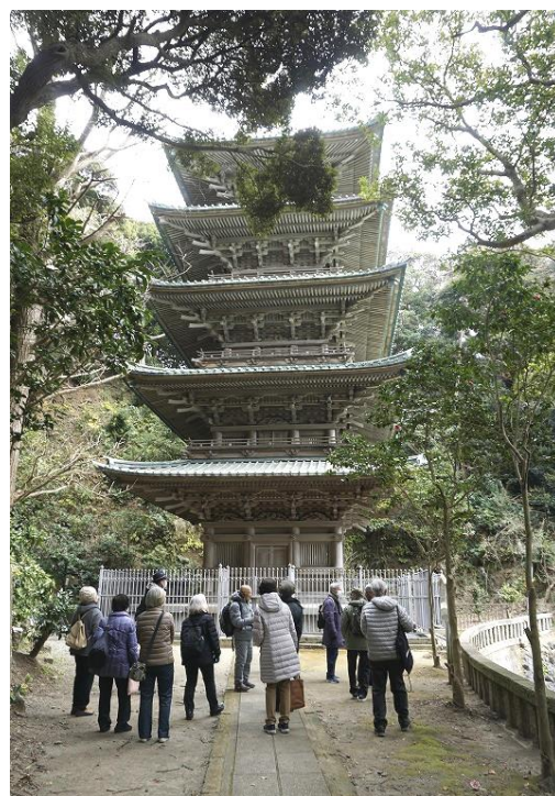
五重塔を見上げる
