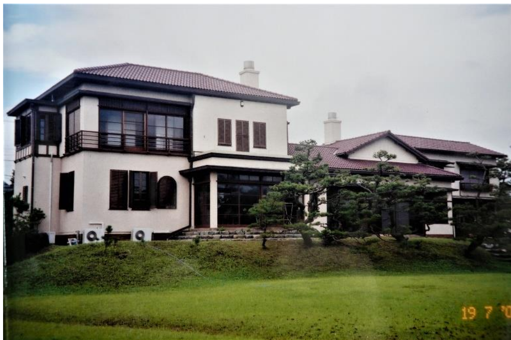
平成7年に大規模修繕が行なわれ屋根は天然スレートから赤い西洋瓦に葺き替えられた
