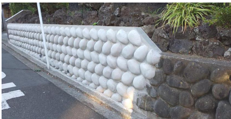
古い玉石垣に新しく玉石垣が繋がれた。型枠を使いコンクリートで仕上げた垣根。神奈川県では昭和 39 年以降、河川での採石が禁止
